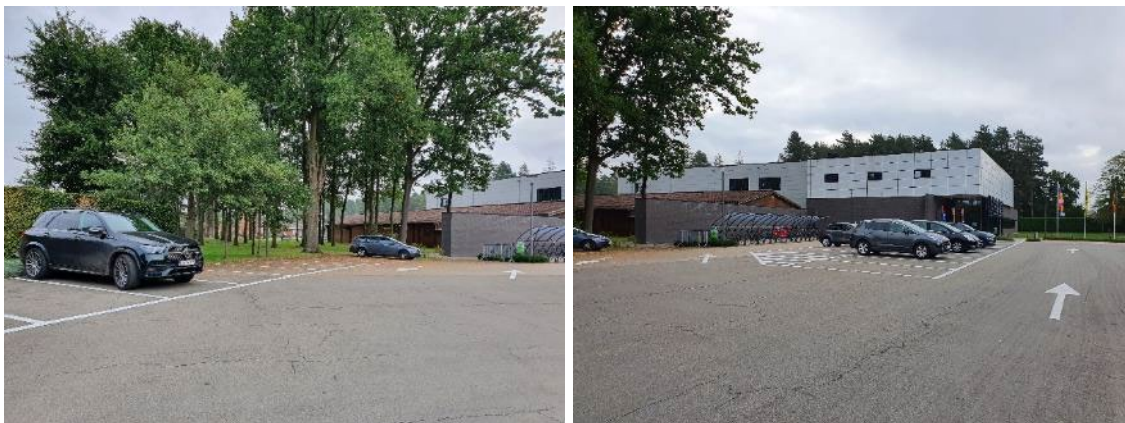
| Sportcomplex "Het Veld" met de voorliggende parking
